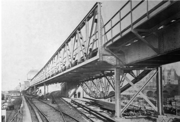
Brückenkonstruktion Gleisdreieck, Berlin; Foto: Stiftung Kunstgussmuseum Lauchhammer, Archiv
